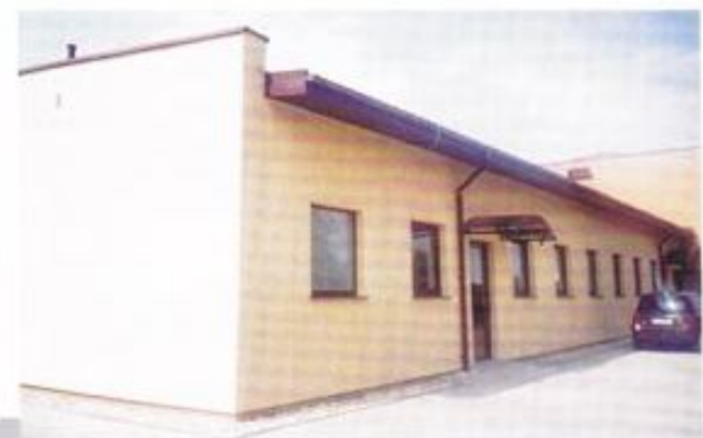
Część techniczna obiektu, w której mieszczą się m.in. chłodnie i laboratoria.
